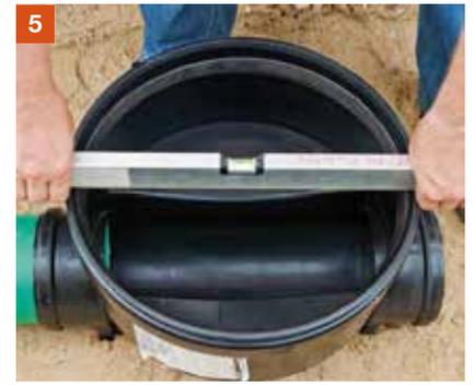
Der Schachtboden und die angeschlossenen Rohre sind entsprechend mit Sand, Kies oder sandigem Kies (Größtkorn 20mm) zu verfüllen. Hierbei ist darauf zu achten, dass der Schachtboden lagenweise (max. 30cm) von allen Seiten verfüllt und mit leichtem Verdichtungsgerät verdichtet wird. Es ist eine Proctordichte von  $D_{pr} \geq 97\%$  zu erreichen!
