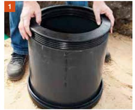
Durch das Teleskoprohr ist nun eine exakte Höhenanpassung entsprechend den Planungsvorgaben möglich. Hierbei ist auf eine Mindesteinstecktiefe des Teleskoprohres in der Teleskopmanschette von min. 100 mm zu achten. Der Schacht ist nun lagenweise (max. 30cm) entsprechend weiter zu verfüllen und zu verdichten.
