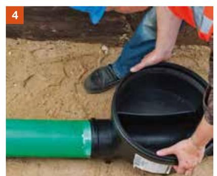
Der Schachtboden ist nun gemäß den Planungsvorgaben auszurichten. Hierbei ist der Schachtboden entsprechend dem erforderlichen Gefälle im Gerinne auszurichten. Zusätzlich ist darauf zu achten, dass die Schachtrohrmuffe senkrecht zur Rohrachse steht.
