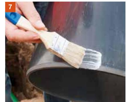
Das entgratete Ende des Schachtrohres ist bis zum Anschlag (Markierung) in den Schachtboden einzustecken. Die Baugrube ist lagenweise (30cm) entsprechend zu verfüllen und mit leichtem Verdichtungsgerät zu verdichten.
