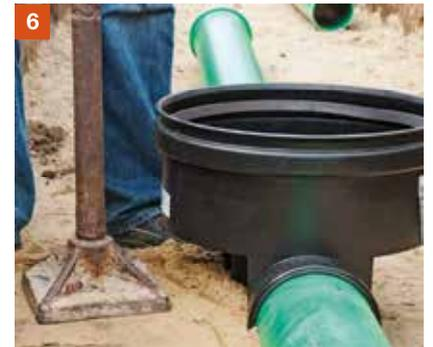
Das Schachtrohr ist gegebenenfalls zu säubern und am entgrateten Ende gleichmäßig mit Gleitmittel zu versehen. Zur Kontrolle der Einstecktiefe ist die Muffentiefe auf dem Schachtrohr zu markieren.
