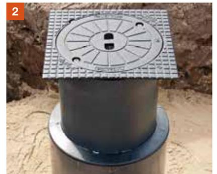
Das Auflager ist entsprechend der Belastungsklasse (B125 / D400) gleichmäßig um das Schachtrohr auszuführen. Je nach Belastung kann ggf. ein größeres Auflager aus Ortbeton erforderlich werden. Die Teleskopabdeckung ist vollflächig und ohne Punktlasten in das Ortbetonaufleger einzubetten und der Oberflächenaufbau gem. Planungsvorgaben zu erstellen.
