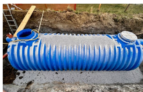
30.000 Liter PE-Tank/Baugrube
