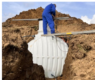
4. Wasserbefüllung sowie Tankhinterfüllung nach Einbauanleitung
