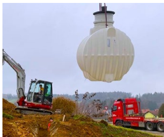
1. Versetzen des PE-Tanks – Hebeösen befinden sich am Tanksystem
