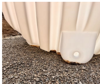
2. Ebene Baugrubensohle mittels Ausgleichsschicht
