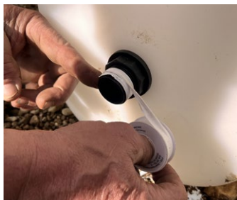
3. Die Gewindestutzen mit Teflon-Dichtbbändern
