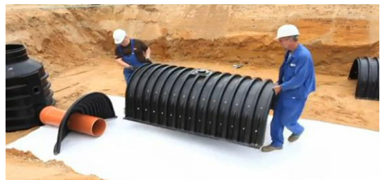
Bild 8: Anschluss an den Zulaufschacht
