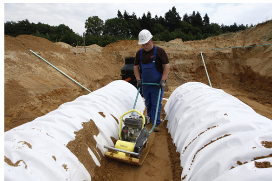
Bild 12: Verdichten mit kleinem Verdichtungsgerät zwischen den Tunnelreihen
