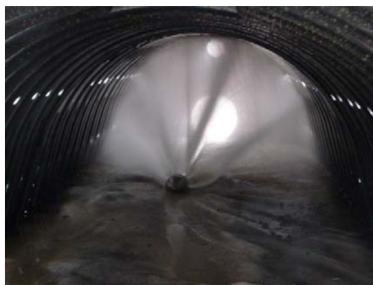
Bild 15: Hochdruckspülreinigung
