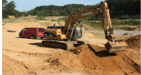
Bild 5: Ausheben der Baugrube
