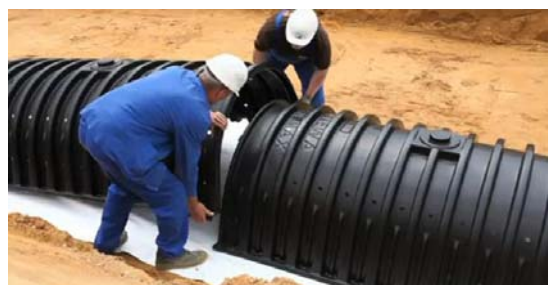
Bild 9: Formschlüssige Verbindung von zwei Tunnelelemente durch Überlappung
