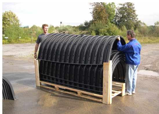
Bild 2: Abheben der Tunnelemente
