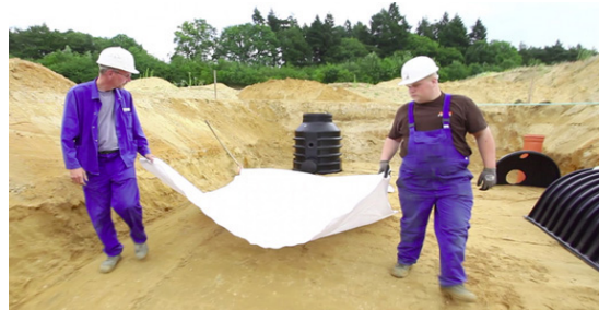
Bild 7: Geotextilgewebe im Bodenbereich
