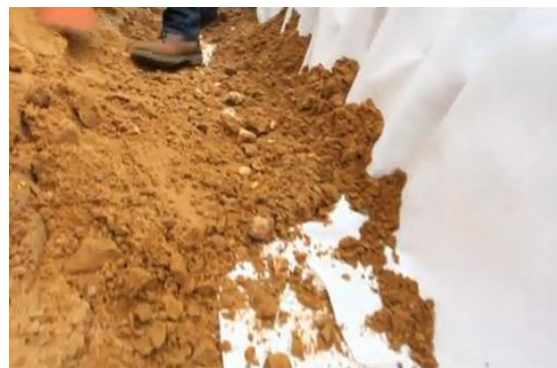
Bild 11: Anschütten des Geotextils zur Fixierung
