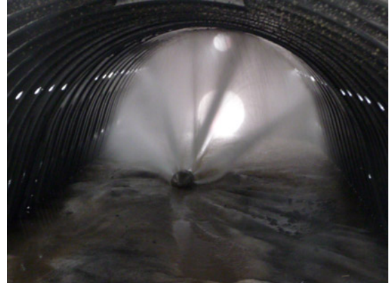
Bild 4: Spüldüse beim Reinigungsvorgang
