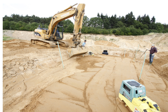
Bild 13: Überdeckung der Tunnelelemente
