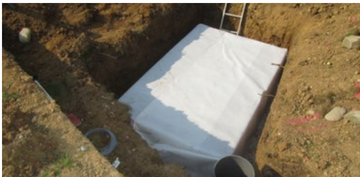
Bild 7: Vor der Vliesummantelung des waterloc® Sickerrigol muss der Zu-/ Ablaufstutzen montiert werden. Mittels einer mitgelieferten Adapterplatte für Rohrdurchmesser DA110/160/200 ist der Innendurchmesser vom gewünschten Zulaufrohr zu markieren und bauseits mittels Stichsäge zu öffnen. Nun kann die Adapterplatte mit dem Zu-/ Ablaufstutzen am waterloc® fixiert werden und die Zulaufleitung wird mit dem waterloc® Rigol verbunden.
