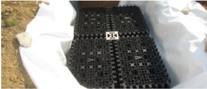
Bild 6: Die oberste waterloc® Reihe ist an den Kreuzungspunkten mittels Verbindungselementen TYPE 2 nochmals in Ihrer Position zu fixieren.
