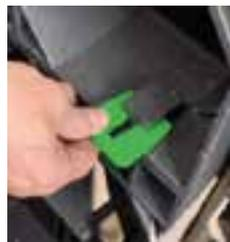
Grüne Befestigungs-Clips zur Verbindung der Rahmenelemente.
