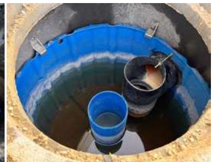
Verbau in Standard-Betonschacht
