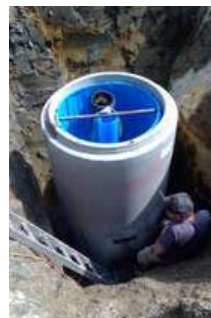
Verbau in Standard-Betonschacht
