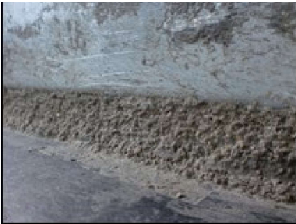
Verfüllter Zwischenraum mit TerraFill-M
