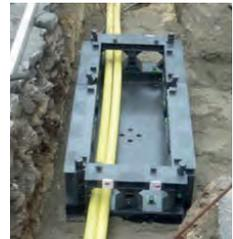
Rahmenelemente auf das zu überbauende Rohr setzen und mit Bodenplatte verbinden.
