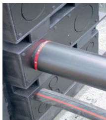
Standard-Adapterplatten ohne Sollschnittstellen (Bildbsp.: mit Sollschnittstellen)
