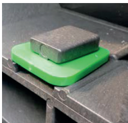
Grüne Befestigungs-Clips zur Verbindung der Rahmenelemente.
