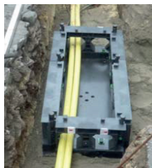
Rahmenelemente auf das zu überbauende Rohr setzen und mit Bodenplatte verbinden.
